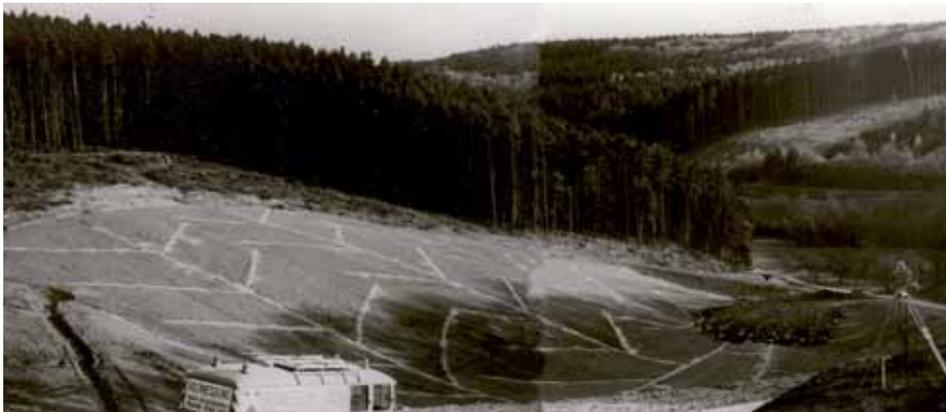
*Deponiefläche der Erweiterung mit Basisabdichtung und Sickerwasserdrainage im Jahr 1977.*
