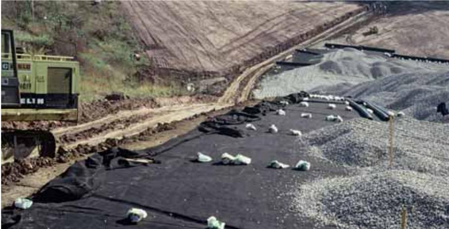
*Erweiterungsabschnitt 1: Basisabdichtung mit Entwässerungsschicht und Sickerwasserdrainagerohren*
