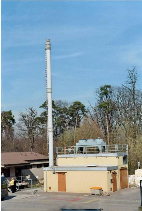
Auf der **ehemaligen Hausmülldeponie Katzenbühl** wird Deponiegas abgesaugt und verwertet. Dabei werden jährlich durchschnittlich 1,64 Millionen kWh Strom erzeugt, der in das Netz der EnBW eingespeist wird.
